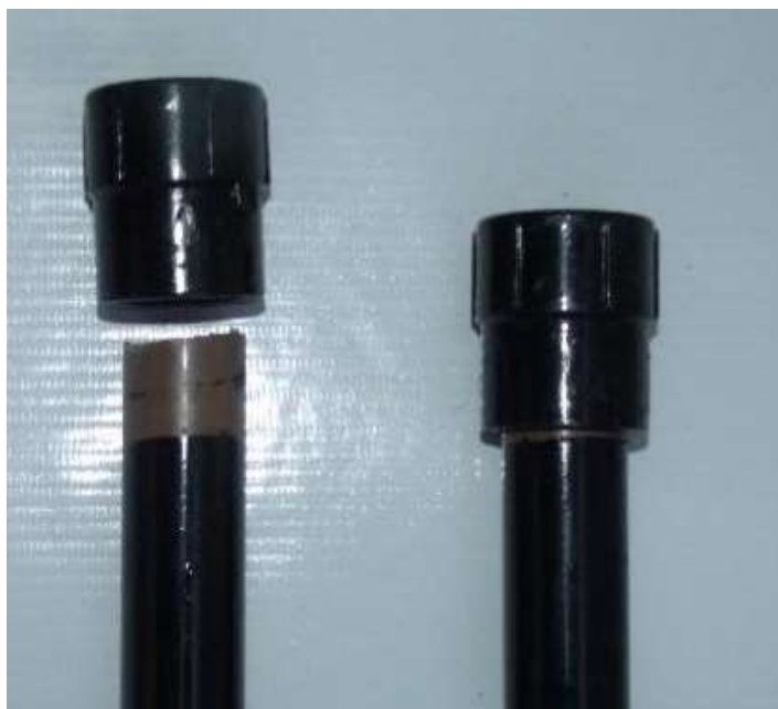
Figura 96 - Colocação dos adaptadores ao cano.
