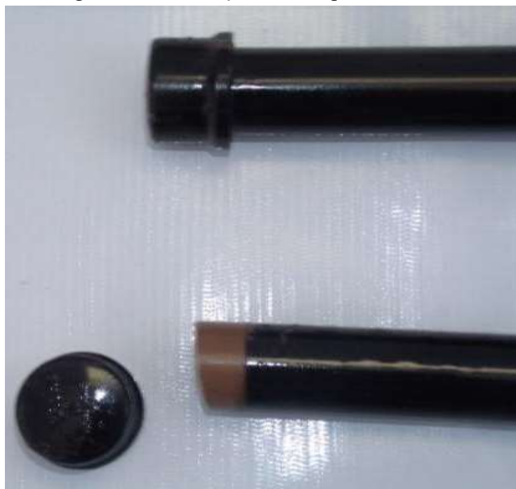
Figura 85 - Colocação dos tampões nos canos.
