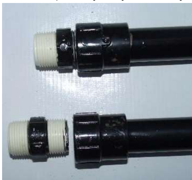
Figura 97 - Colocação das nípel rosqueável aos adaptadores.
